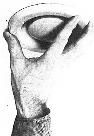
Bild 6. Demontering av frånluftventil.
