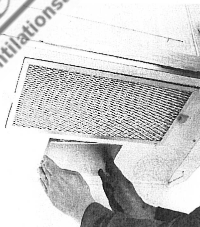
Bild 5. Demontering av lampglas för spisbelysning.
